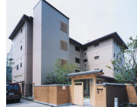
グループホームみなせ 号館
