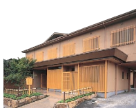
グループホームみなせ 号館
