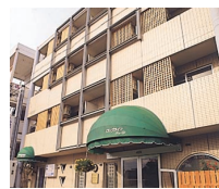
ロングライフ長居公園 号館
