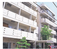
ロングライフ長居公園 号館
